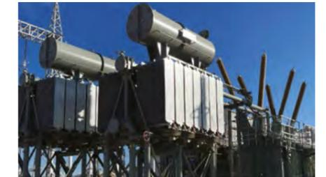
Figura 10 | Transformador de Desplazamiento de Fase de 330kV
