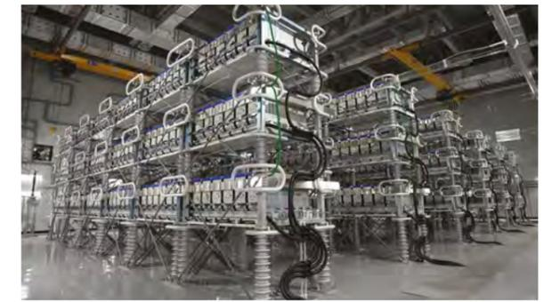
Figura 4 | Válvula Convertidora de Yangju
