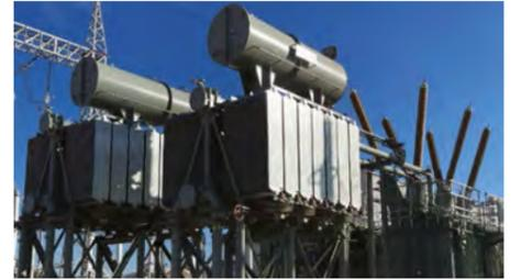
그림10 | 330kV Phase Shifting Transformer
