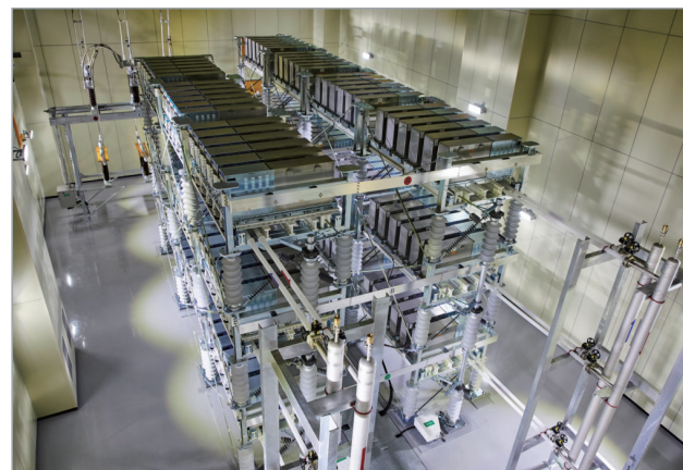
[Fig. 3] Hyosung's MMC STATCOM
