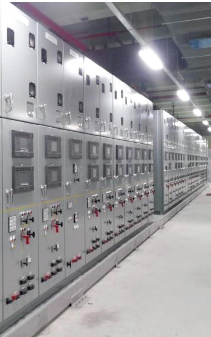
도심 변전소의 공간 부족 및 부지 매입 비용의 증가로 전통적인 AIS (Air Insulated Switchgear)에서 MV GIS (Medium Voltage Gas Insulated Switchgear) 제품으로 변경하려는 고객 요구가 증가하는 추세입니다. 또한, 기후변화 위기로 기존 절연매질 SF<sub>6</sub>에서 친환경 절연매질(GWP “0”, Global Warming Potential:CO<sub>2</sub> 대비 온난화 지수)을 적용한 MV GIS의 적용이 점차 확대되고 있습니다.
