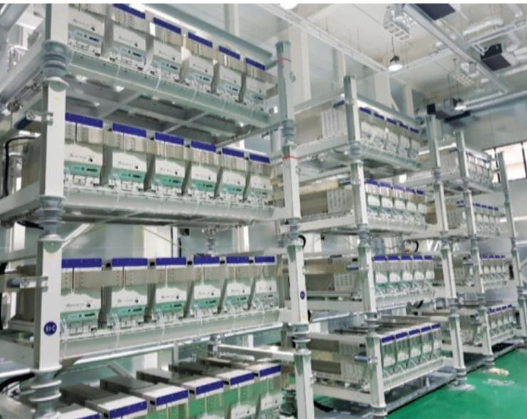
중공업연구소는 2012년부터 전압형 HVDC를 개발하고 있습니다. 국내 최초로 전압형 HVDC를 개발 하는 것으로 컨버터 밸브 모듈을 직렬로 연결하여 대용량의 전력변환설비를 구현하는 MMC(Modular Multilevel Converter) 방식을 적용하였습니다. 2017년에 20MW의 파일럿 프로젝트를 통해 제주도 행원 실증단지에서 해상풍력 연계 용으로 실증을 성공적으로 마쳤습니다. 이 기술을 바탕으로 현재는 한국전력공사 양주변전소에 120kV 200MW 전압형 HVDC를 설치하는 과제를 진행 중입니다.
